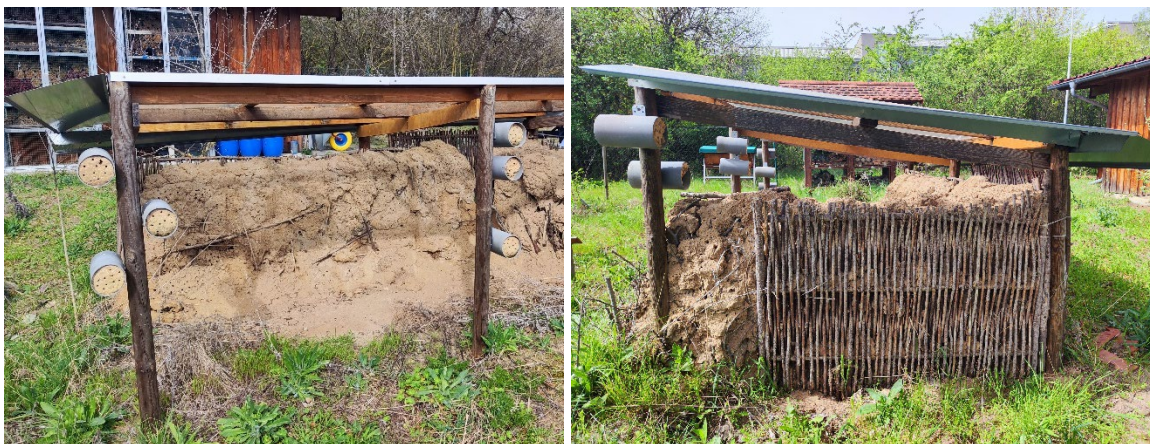
Vorder- und Rück- (bzw. Seiten-) ansicht einer Steilwand mit Weidezaun
